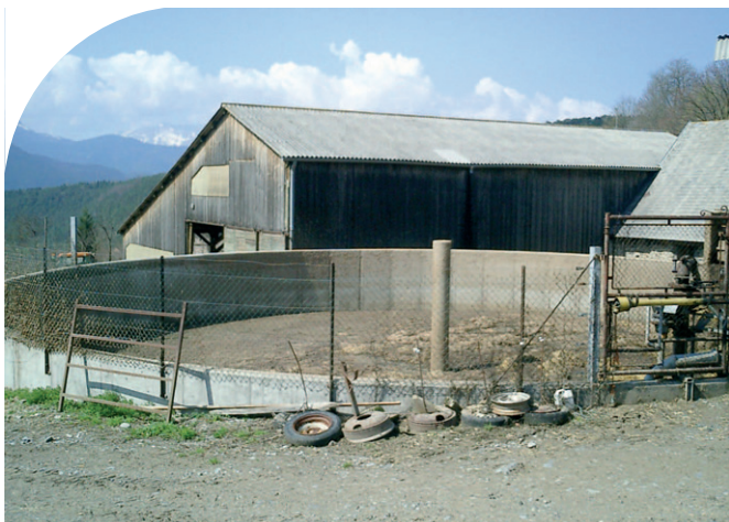
Capacité de fosse à vérifier.
