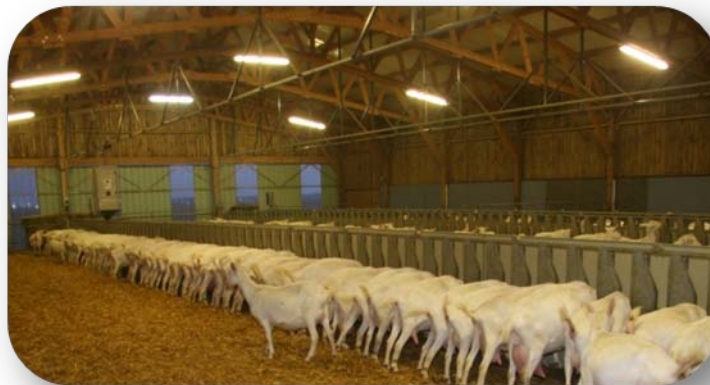
Installation photopériodique avec des lampes fluorescentes
