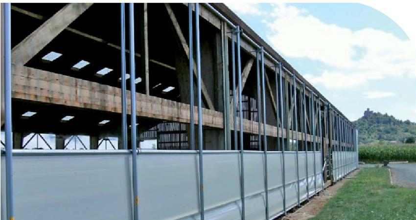
Le bardage amovible, une solution pour créer un courant d'air.
